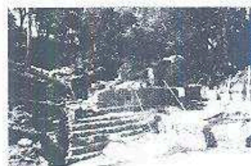
Fachada norte trabajos de restauración en proceso
